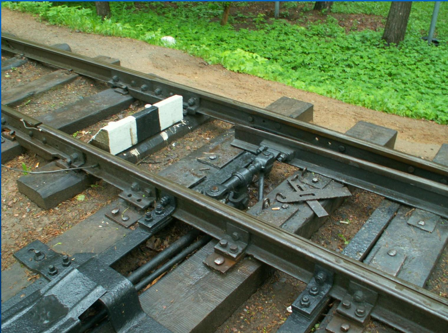
**Остряки** изготавливают из остряковых рельсов ОР50, ОР65, ОР75 пониженной на 40 мм высоты. Пониженная высота остряков принята для того, чтобы не ослаблять подошву рамного рельса, к которому прижимается остряк.
