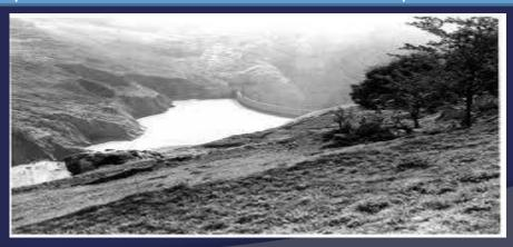
Плотина Вайонт — арочная бетонная плотина рядом с горой Монте Ток на реке Вайонт, притоке реки Пьяве в провинции Венеция на севере Италии, построенная в 1961 году, в основном, для выработки электроэнергии. Имеет высоту 261,6 м, длину по гребню 190 м, ширину по основанию 23 м и ширину по гребню, равную 3,9 м, за что считается одной из самых «изящных» плотин в мире. Водохранилище, образуемое плотиной, имеет объем 0,169 км³.
