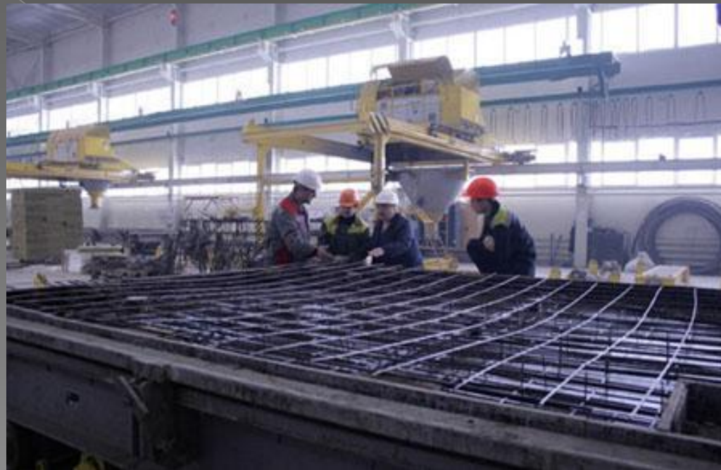
Установка арматурного каркаса
