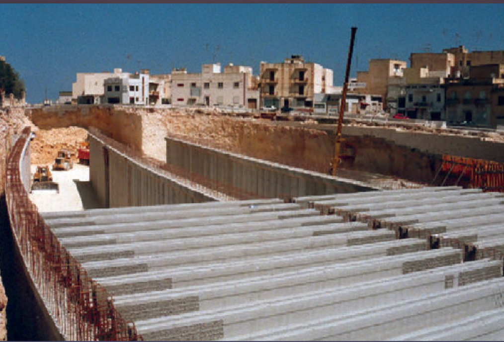
Плиты покрытия (перекрытия) высотой 1000 мм с видимой преднапряженной арматурой и поперечной стальной арматурной сеткой
