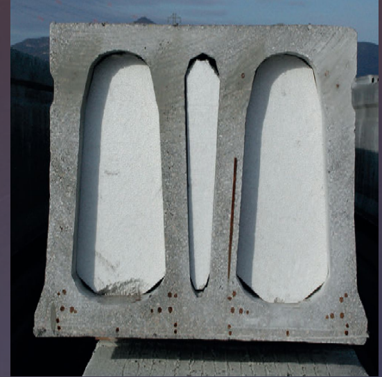
Плиты покрытия (перекрытия) высотой 1000 мм с видимой преднапряженной арматурой и поперечной стальной арматурной сеткой
