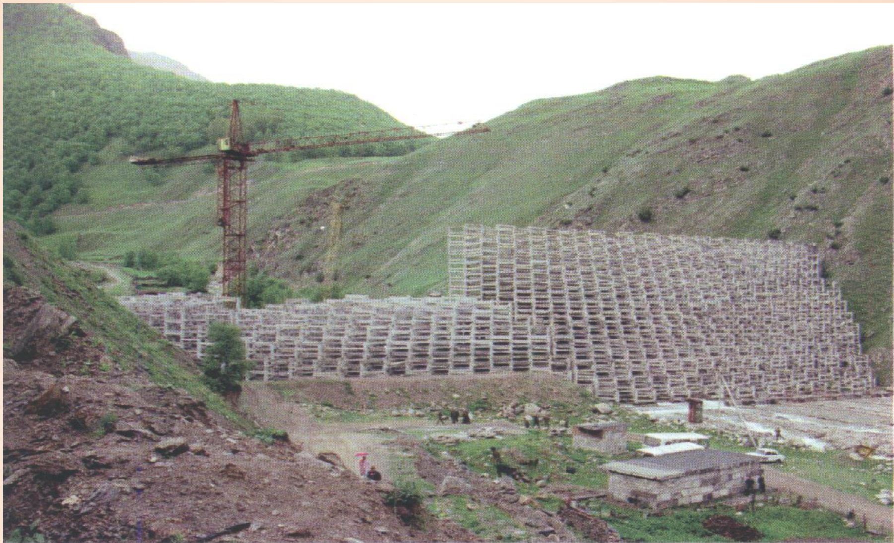
Строительство селезащитной плотины в Кабардино-Балкарской республике
