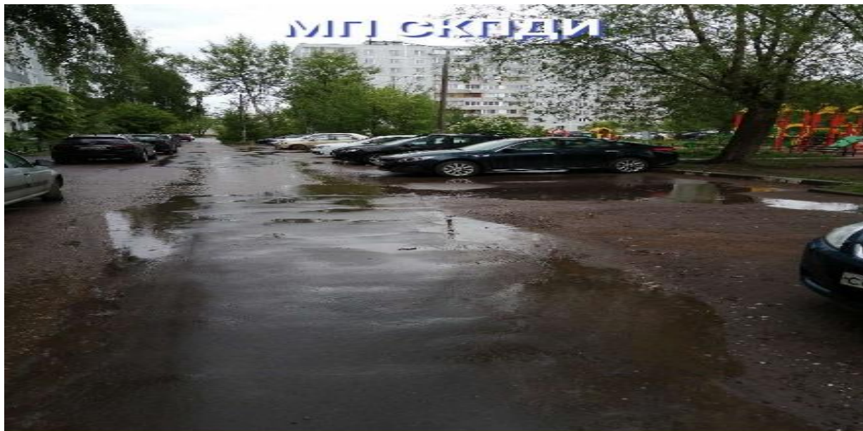
Дворовая территория Ул. Володарского 13, 15, 17,19,23
