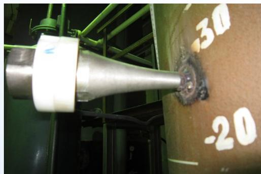
Крепление УЗ излучателей новой конструкции на колонне СНК 1700.
