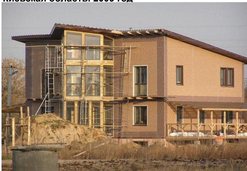
Дом облицован фасадными плитами
