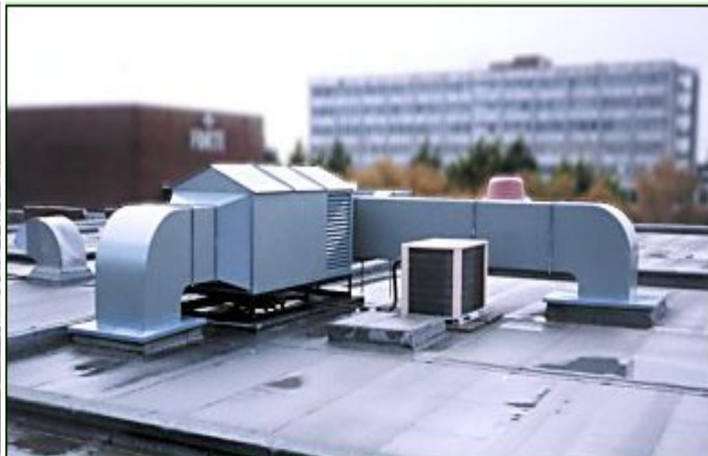
Воздухозаборные отверстия для наружного воздуха должны периодически осматриваться для проверки их физического состояния.
