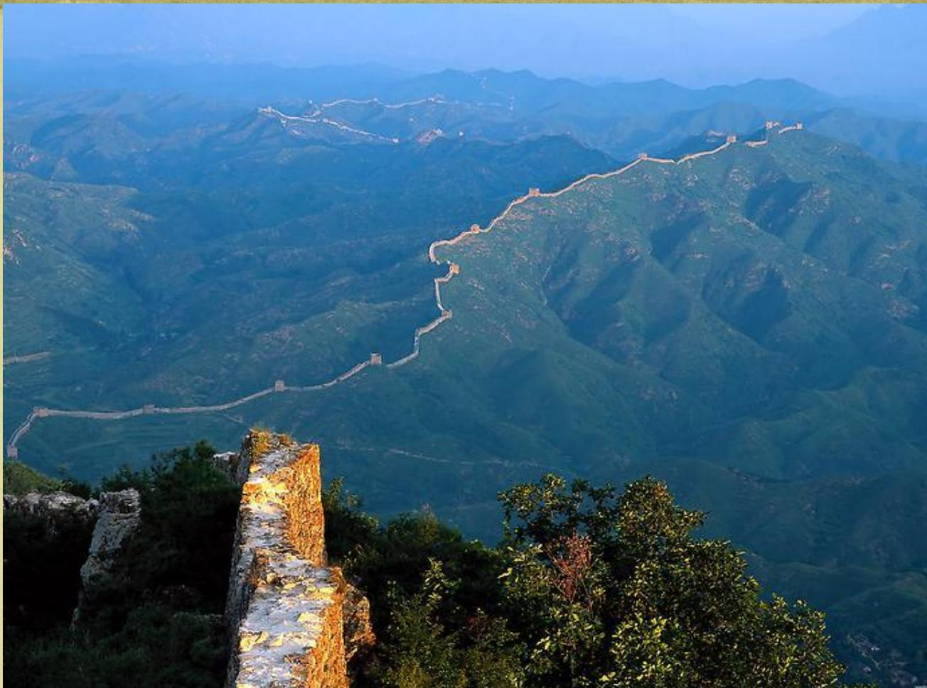
**В результате строительства Великая китайская стена протянулась на 4 тысячи километров. В высоту она достигала 10 метров, в ширину 5,5 метров, а через каждые 60-100 метров высились сторожевые башни, выстой не менее 12 метров. Это величайшее в истории человечества сооружение отделило Китай от степей и кочевых племён.**
