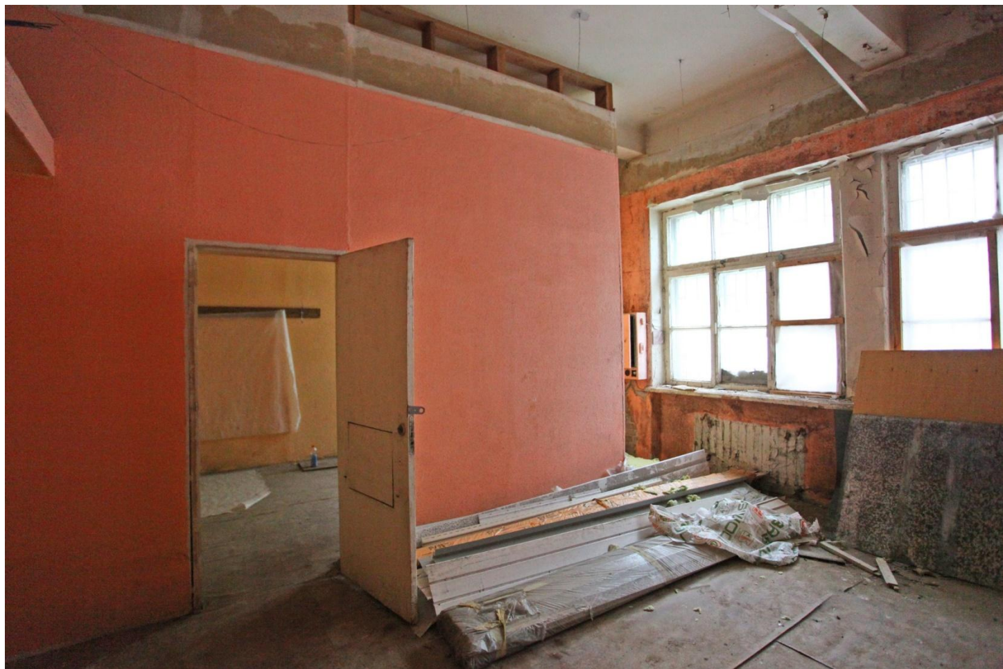
Внутренний вид строящейся православной гимназии
