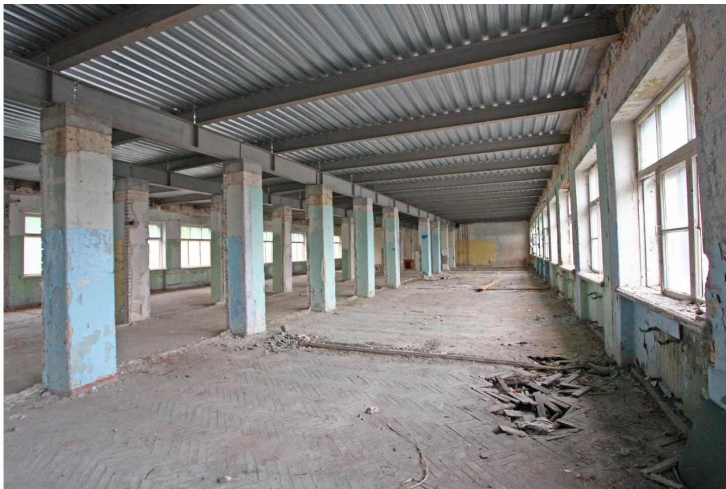
Внутренний вид строящейся православной гимназии
