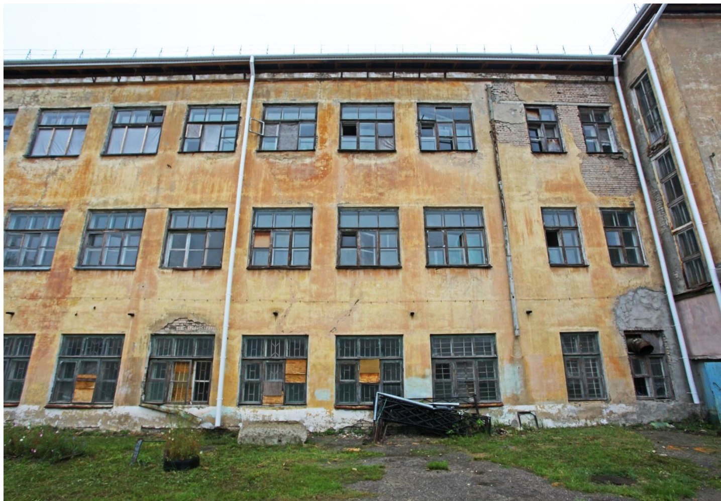
Внешний вид строящейся православной гимназии
