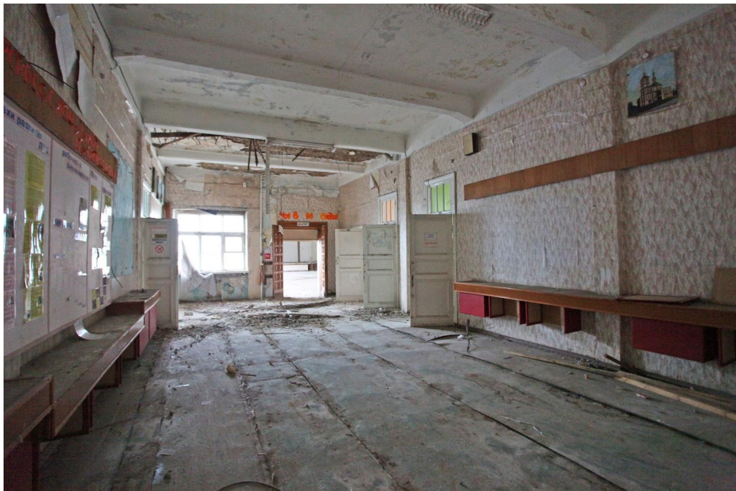
Внутренний вид строящейся православной гимназии
