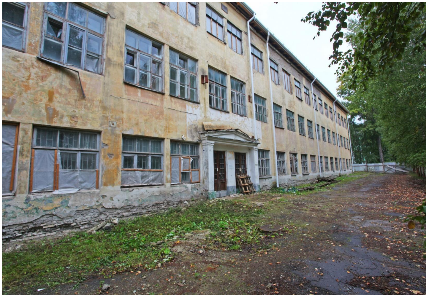
Внешний вид строящейся православной гимназии
