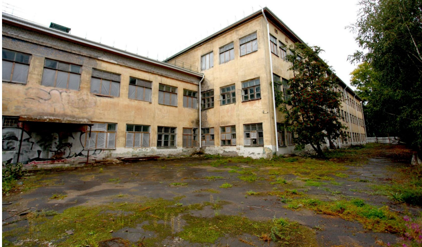
Внешний вид строящейся православной гимназии
