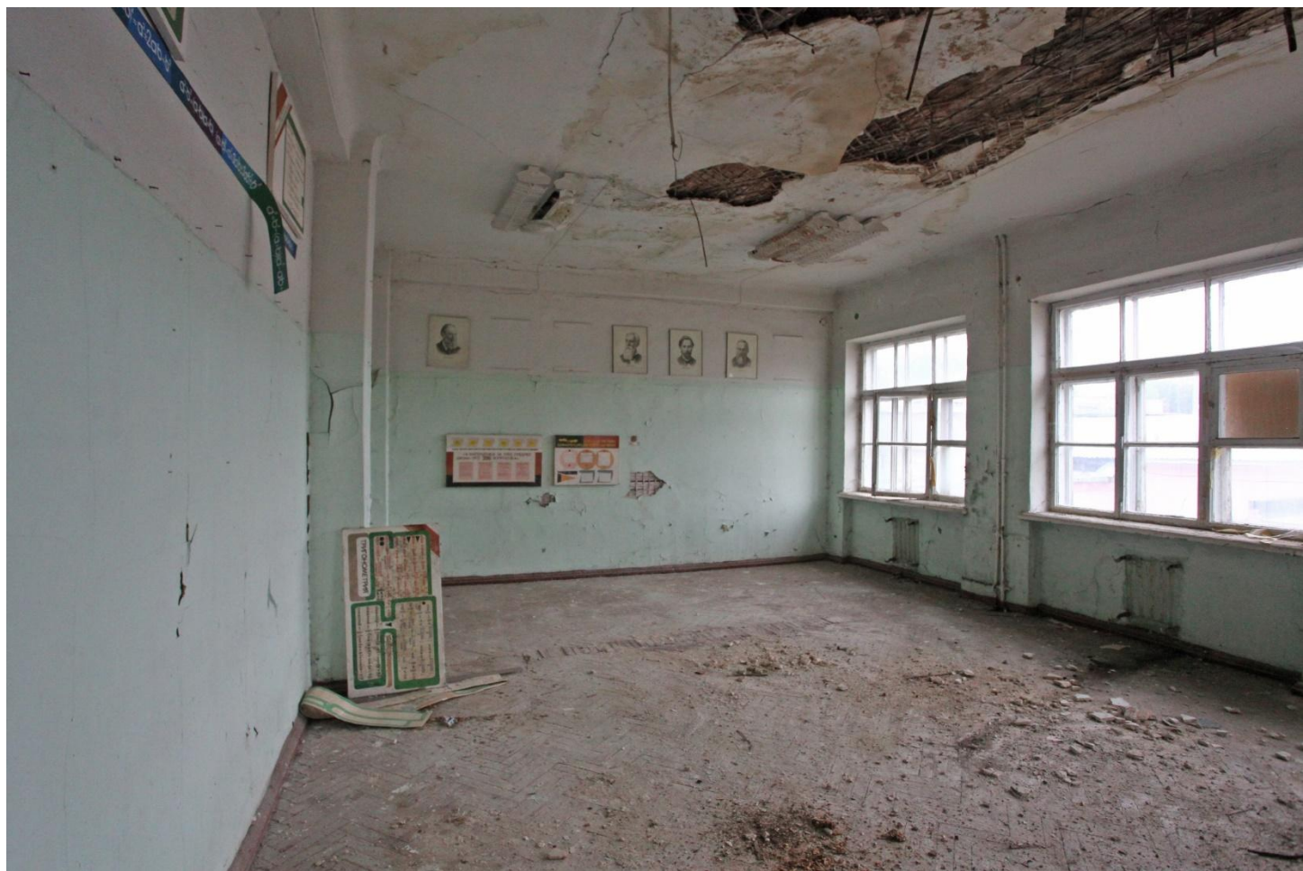
Внутренний вид строящейся православной гимназии
