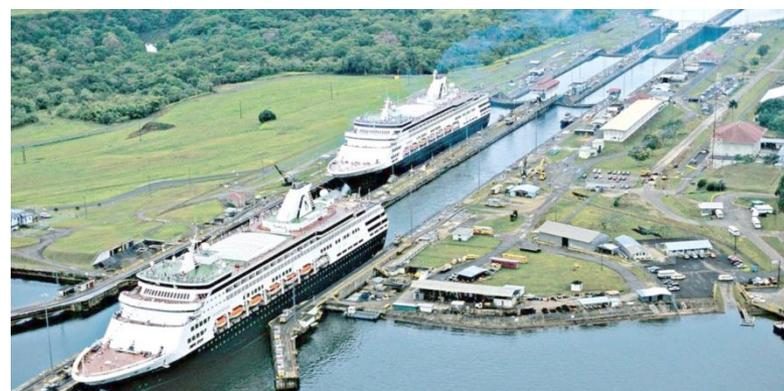
В настоящее время в канале имеются две полосы прохода, однако рассматривается возможность постройки третьей полосы с увеличенными размерами шлюзов для следующего поколения контейнеровозов вместимостью свыше 12000 TEU.
