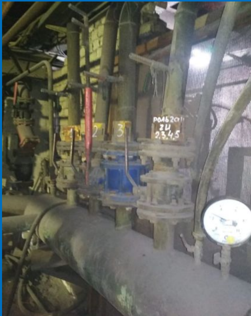
Оборудование ТПМ на участке МНЛЗ при проведении ППР.
