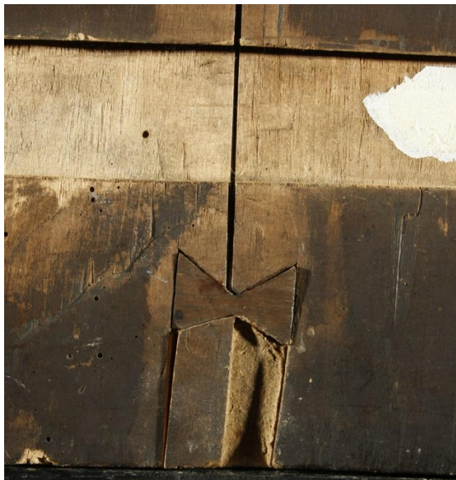
Трещины и утраты фрагментов древесины, утраченные шпонки
