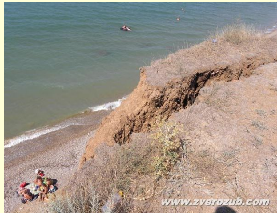
Трещины бортового отпора. Эчки-Даг. Крым
