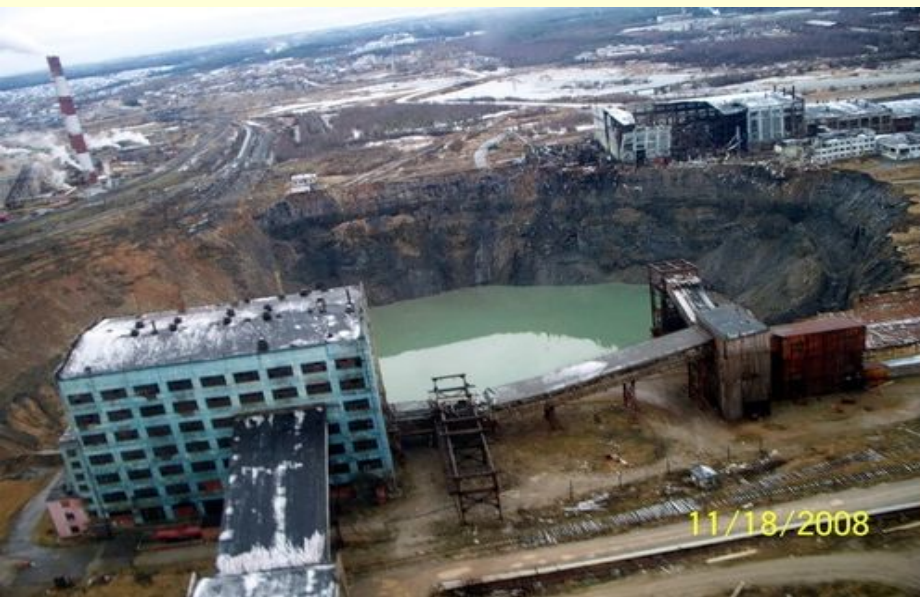
Провал в г. Березники. Шахтное поле БКРУ-1 http://mw2.google.com
