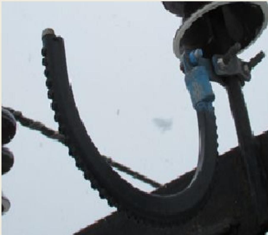
Верховой осмотр разрядников должен производиться на отключенной и заземленной ВЛ. При этом следует проверять :
