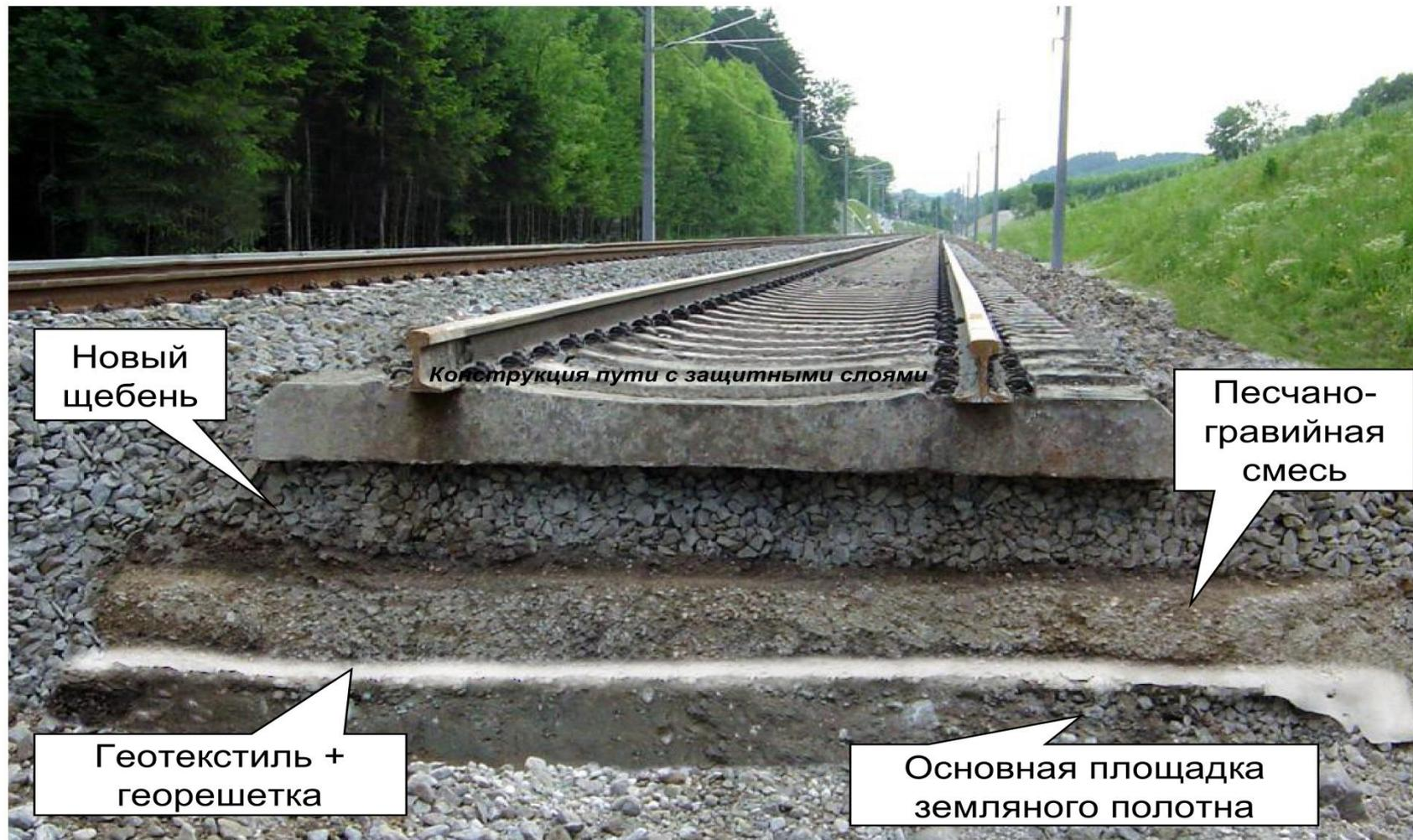
Рис. 3. Современная конструкция верхнего строения пути
