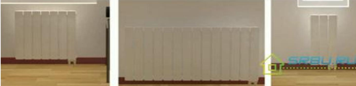
**Литьевые радиаторы** – изготовлены методом литья под давлением, отличаются широкими каналами для горячей воды и прочными толстыми стенками.
