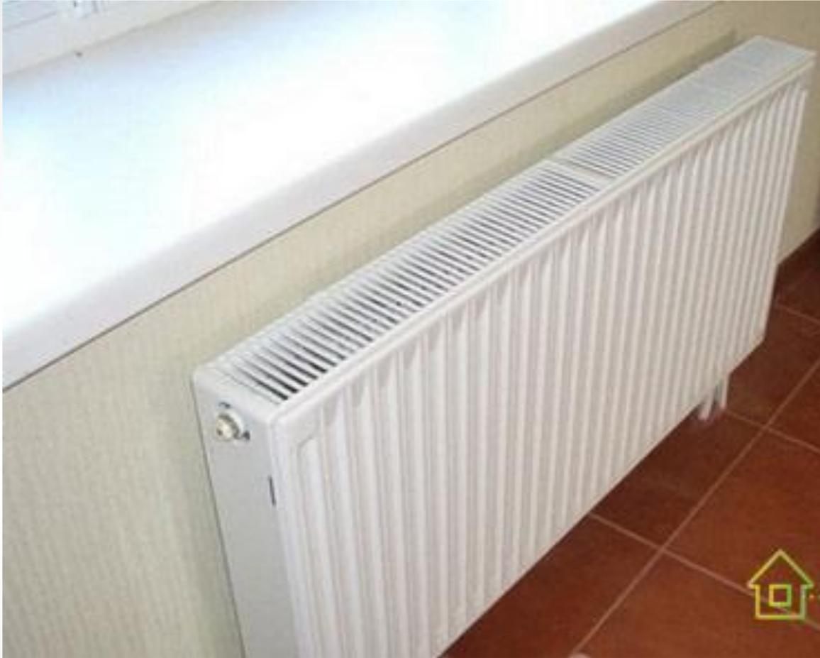
Радиаторы , имеют высокий КПД – до 75%. Внутри радиаторов – одна или несколько нагревательных панелей и конвекторное оребрение.
