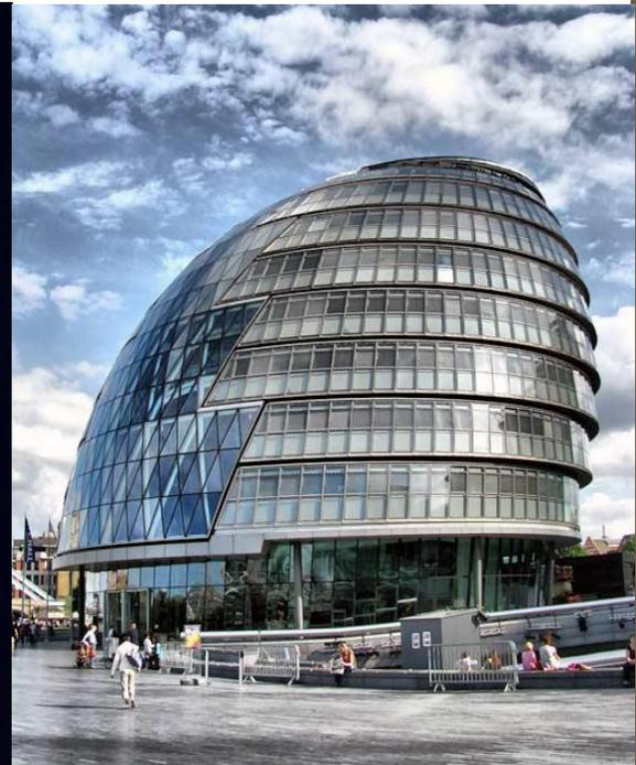
За счет применения мероприятий по энергосбережению (форма здания, ориентация, компактность, наклон здания на 17%), позволило архитектору сократить теплопотери на 25%, а общее потребление энергоресурсов на 75%.
