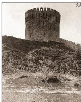
Смоленск. Восточная часть крепостной стены. Городецкая (Орел) башня. Силуэты вымывают песок. Фотографии Е. И. Феррих. 1903. 12,0 × 9,3. Российский государственный архив литературы и искусства, Москва. Фонд 2094, опись 1, дело 1074, л. 53
