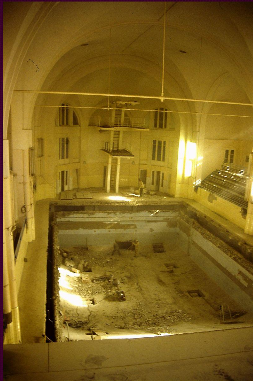
Демонтаж бассейна, 1994 г.
