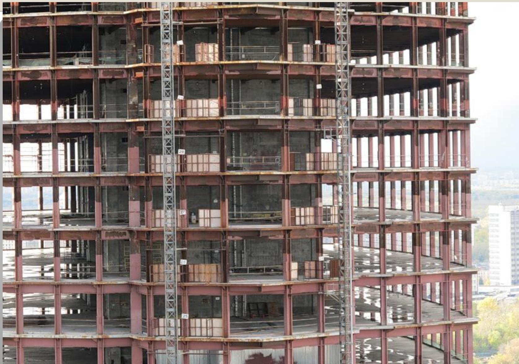
*Рис. конструкция стального небоскреба*
