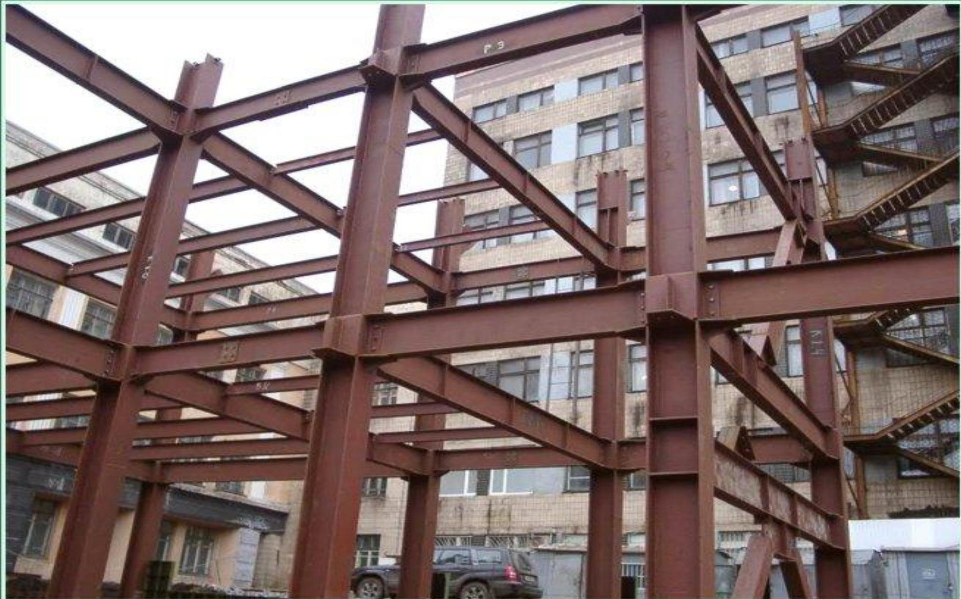
*Рис. Рамный металлический каркас стального здания*
