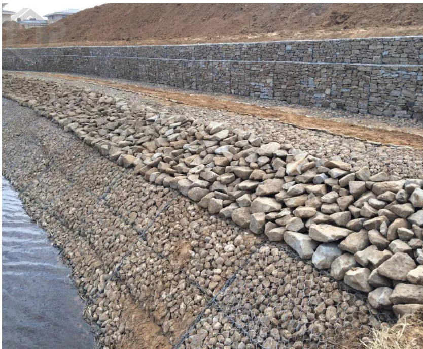
Рис. 3. Вдольбереговой подводный банкет из камня.
