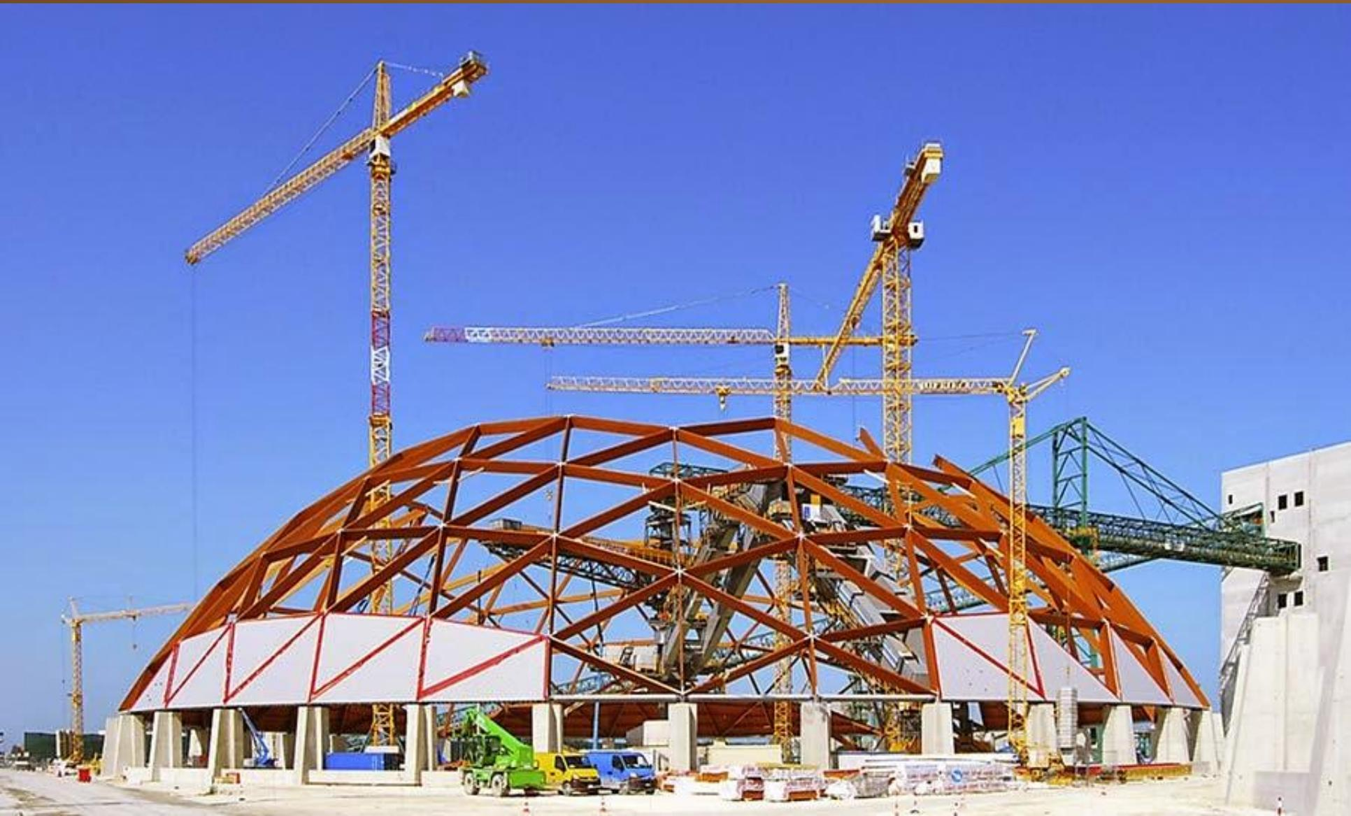
Купол разделен на 5 равных секторов. Основные балки выполнены прямыми, соединяясь в узлах формируют сферическую поверхность купола, образованную плоскими треугольниками. Основные балки имеют длину от 5,4 до 13,8 м. Опорные узлы (40 штук) располагаются на стальном кольце, опирающемся на 40 ж/б опор высотой 6,2 м..
