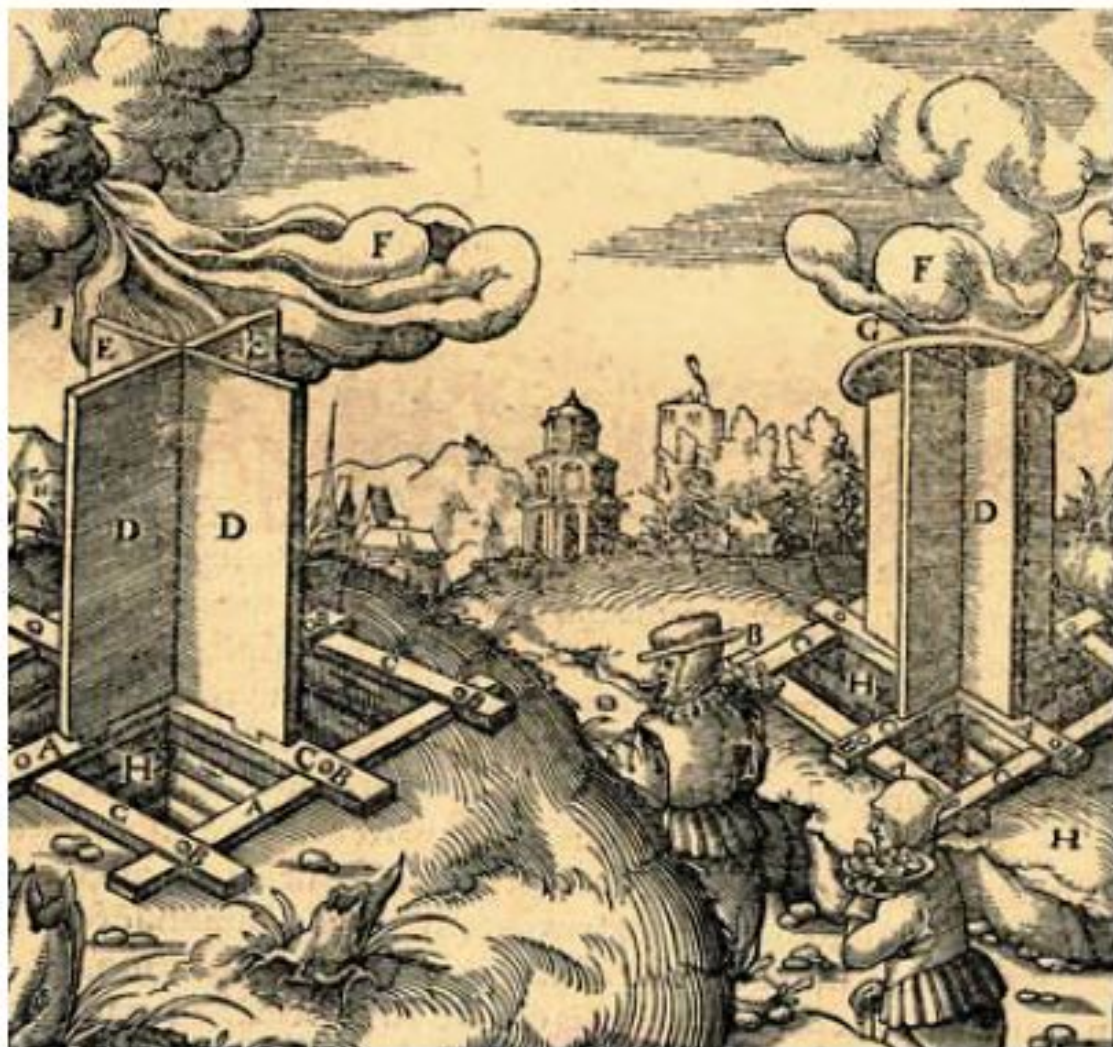
Пассивная система вытяжной вентиляции в шахтах
