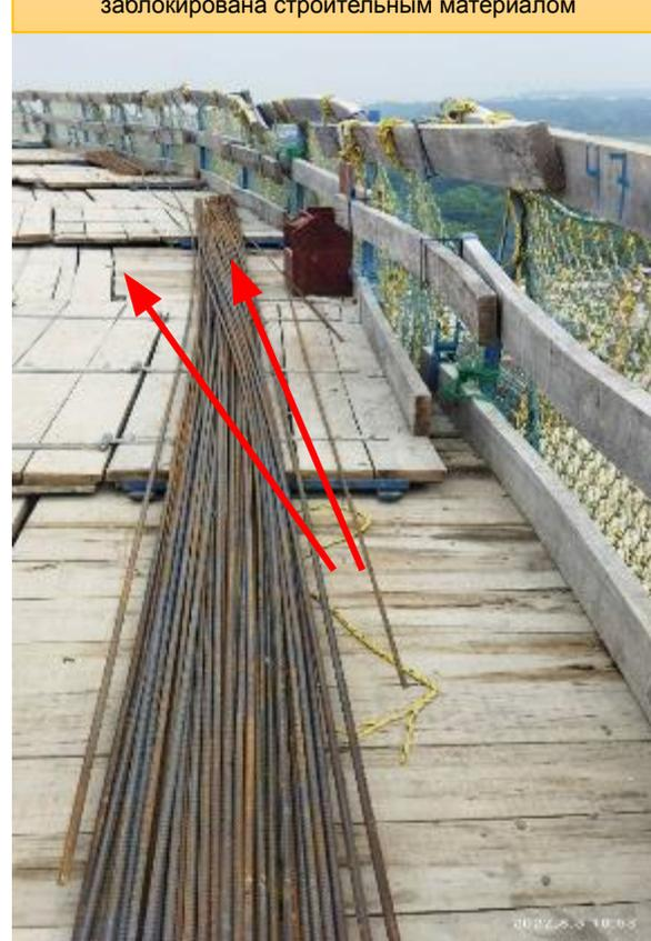
Unguarded/unprotector protruding steel reinforcing./ Незащищенная/незащитная выступающая стальная арматура.
