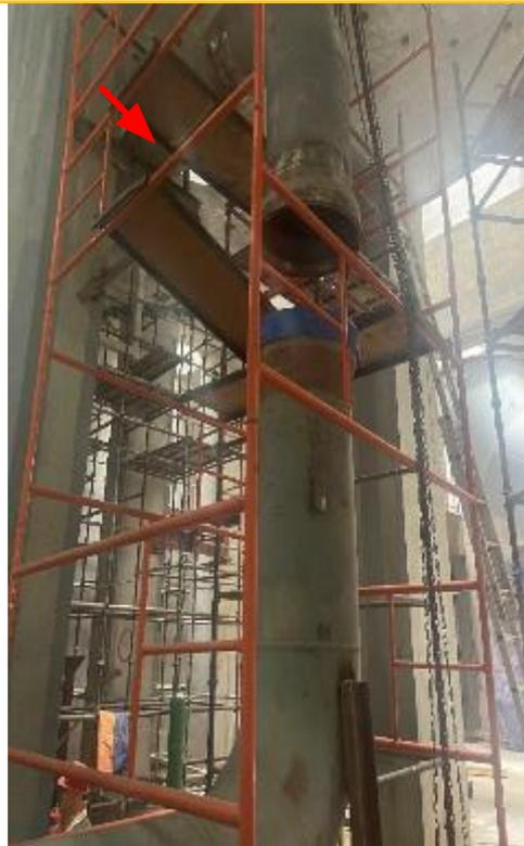
Missing safety lock Latch/Отсутствует защелка предохранительного замка
