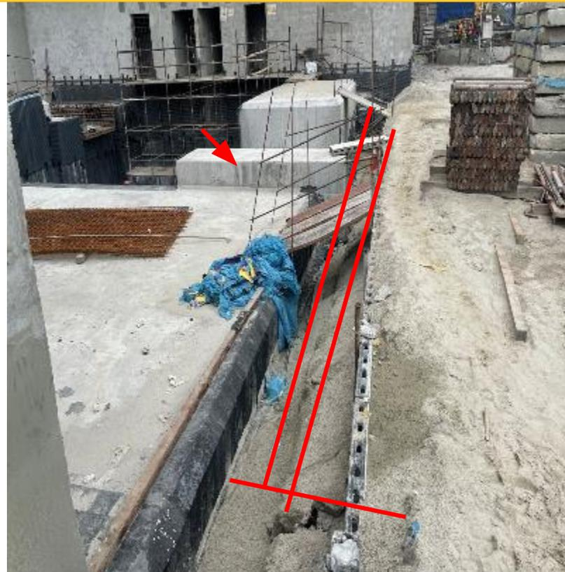
Every open side floor or platform 1.2 m or more above adjacent floor or ground level shall be guarded by a railing/cover by protected cover./Каждый открытый боковой этаж или платформа на высоте 1,2 м или более над соседним этажом или уровнем земли должны быть ограждены перилами/прикрыты защищенным покрытием.
