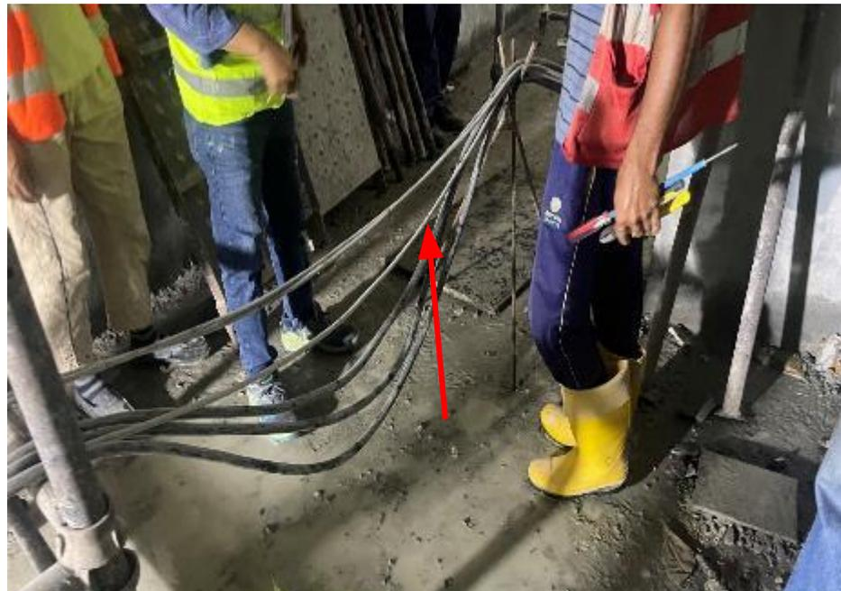
The wiring of temporary electrical networks must be carried out on supports or a structure (height above ground level not less than: 3.5 m, 6.0 m - above the driveways; 2.5 m - above the workplaces./ Разводка временных электросетей должна быть выполнена на опорах или конструкция (высота над уровнем земли, настила не менее: 3,5 м - над проходами; 6,0 м - над проездами; 2,5 м - над рабочими местами.
