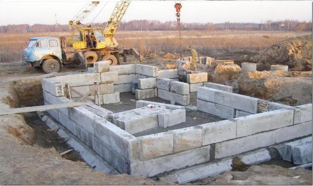
Фундаментные бетонные блоки укладываются на растворе с обязательной перевязкой вертикальных швов, толщина которых принимается равной 20 мм. Вертикальные швы, образуемые торцами блоков, тщательно заполняются раствором. Связь между блоками продольных и угловых стен обеспечивается перевязкой блоков и закладкой в горизонтальные швы арматурных сеток из стали диаметром 6—10 мм.
