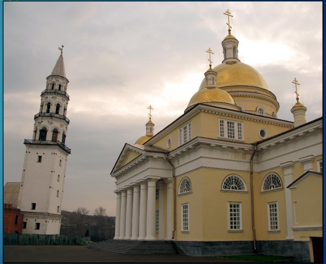
Невьянская наклонная башня
