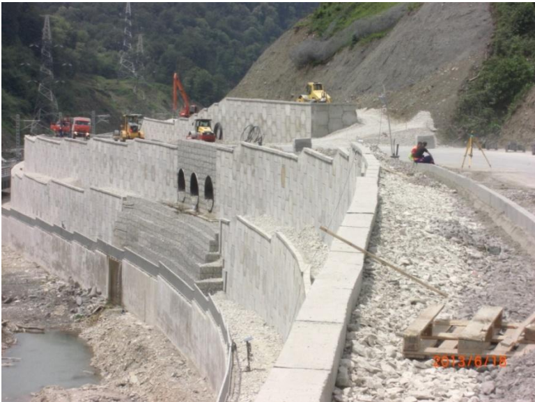
Рис. 7. Схема устройства стенки Терре Арме.
