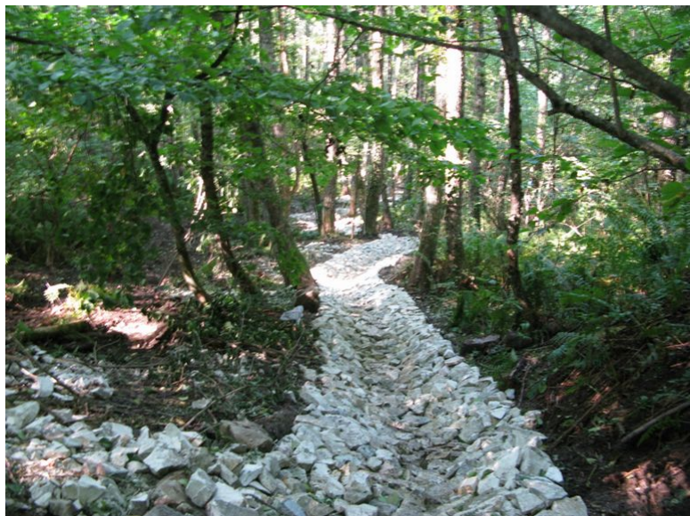
Рис. 1. Водоотводная канава/комбинированный однострунный дренаж
