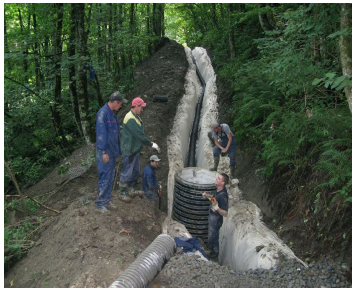
Рис. 2. Однострунный дренаж
