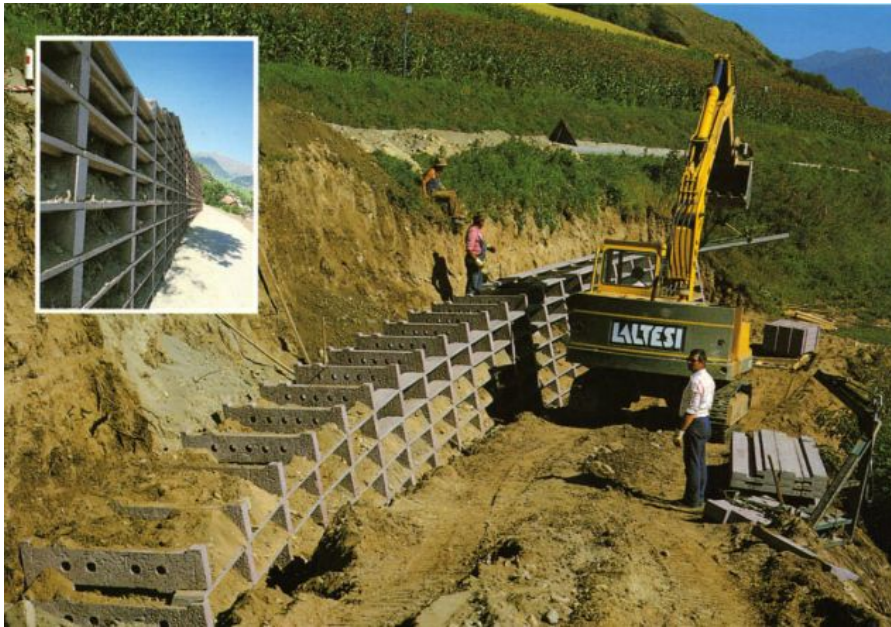
Рис. 6. Схема устройства стенки Крайнерванд.
