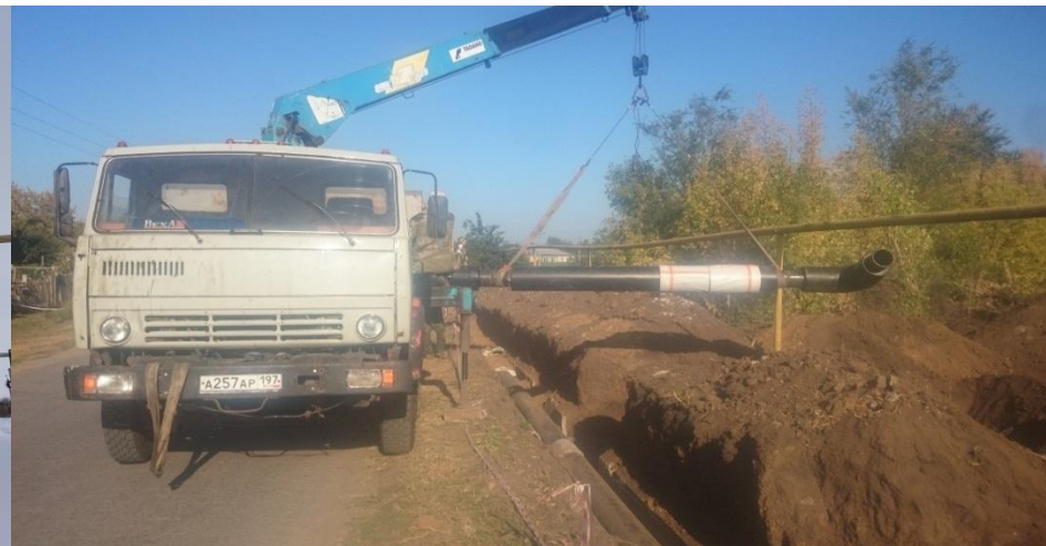
Ремонт тепловых сетей в ООО «СамРЭК – Эксплуатация»
