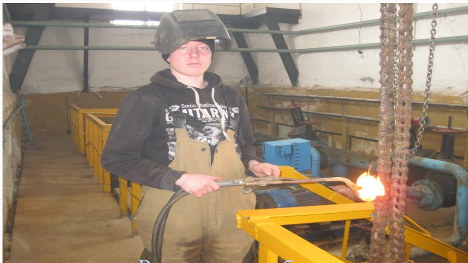
Ремонтные работы в МУП «Вода – 16»
