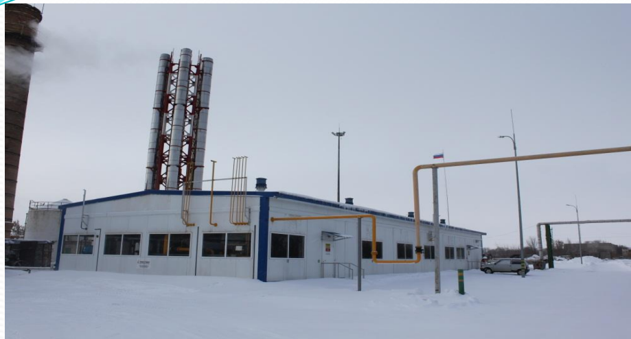
Модульная котельная в селе Приволжье
