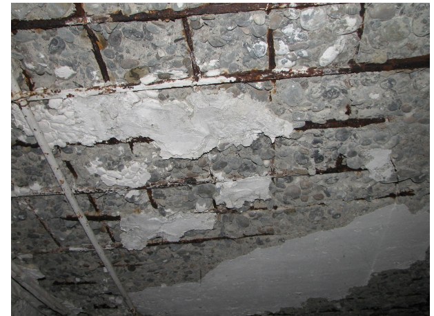
Рис. 7.9. Ялта, Набережная, ул. Краснова, бывшие торговые ряды Стахеева: а – общий вид здания с Набережной; б - коррозия бетона и арматуры плиты перекрытия
