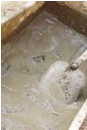
Рис. 7.1. Применение гидравлической извести: а – приготовление растворов; б - бетонный стеновой камень
