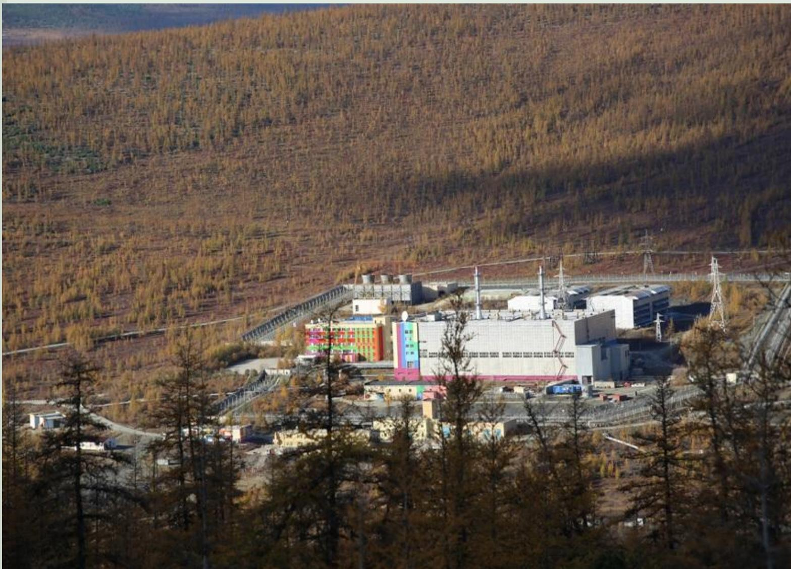
**Станция состоит из четырёх одинаковых энергоблоков общей электрической мощностью 48 МВт с реакторами ЭГП-6. Станция вырабатывает как электрическую, так и тепловую энергию для теплоснабжения города Билибино.**
