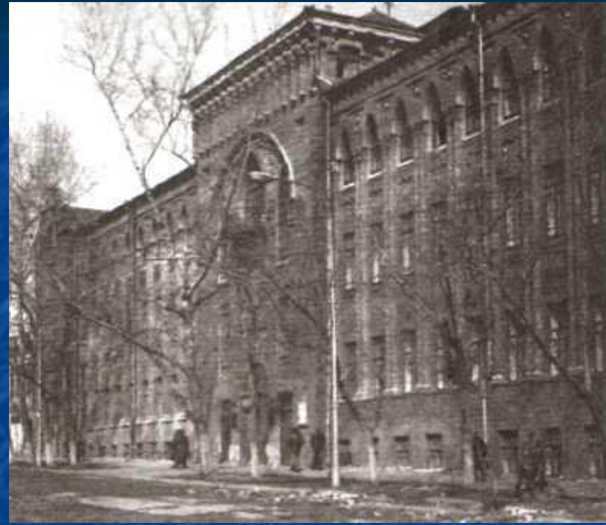
Бывшее училище землемеров. В 1920-е гг. здесь располагался медтехникум, до 1941 г. — дорожный механический техникум НКВД, в 1941—42 гг. — городской эвакуосовет, с 1943 по 1956 гг. обком ВКП(б), с 1956 г. — политехнический институт. Ульяновск, ул. Энгельса, д. №3. 1976 г.
