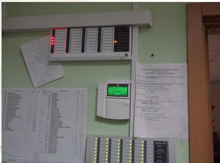
На объекте защиты установлена адресная система пожарной сигнализации, производства ЗАО «Болид»:
