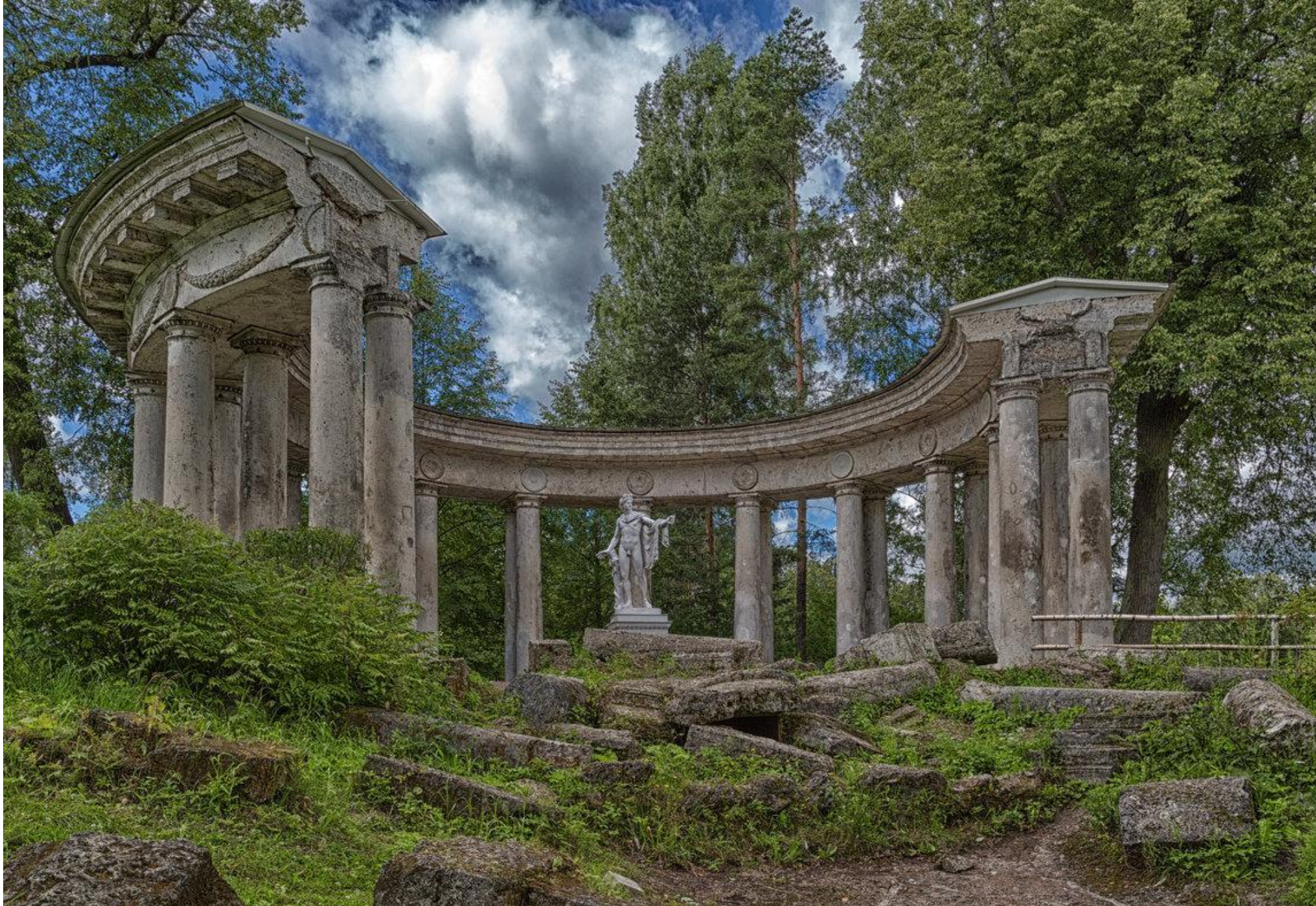
Ч. Камерон Павловск. Искусственная руина. Колоннада Аполлона
