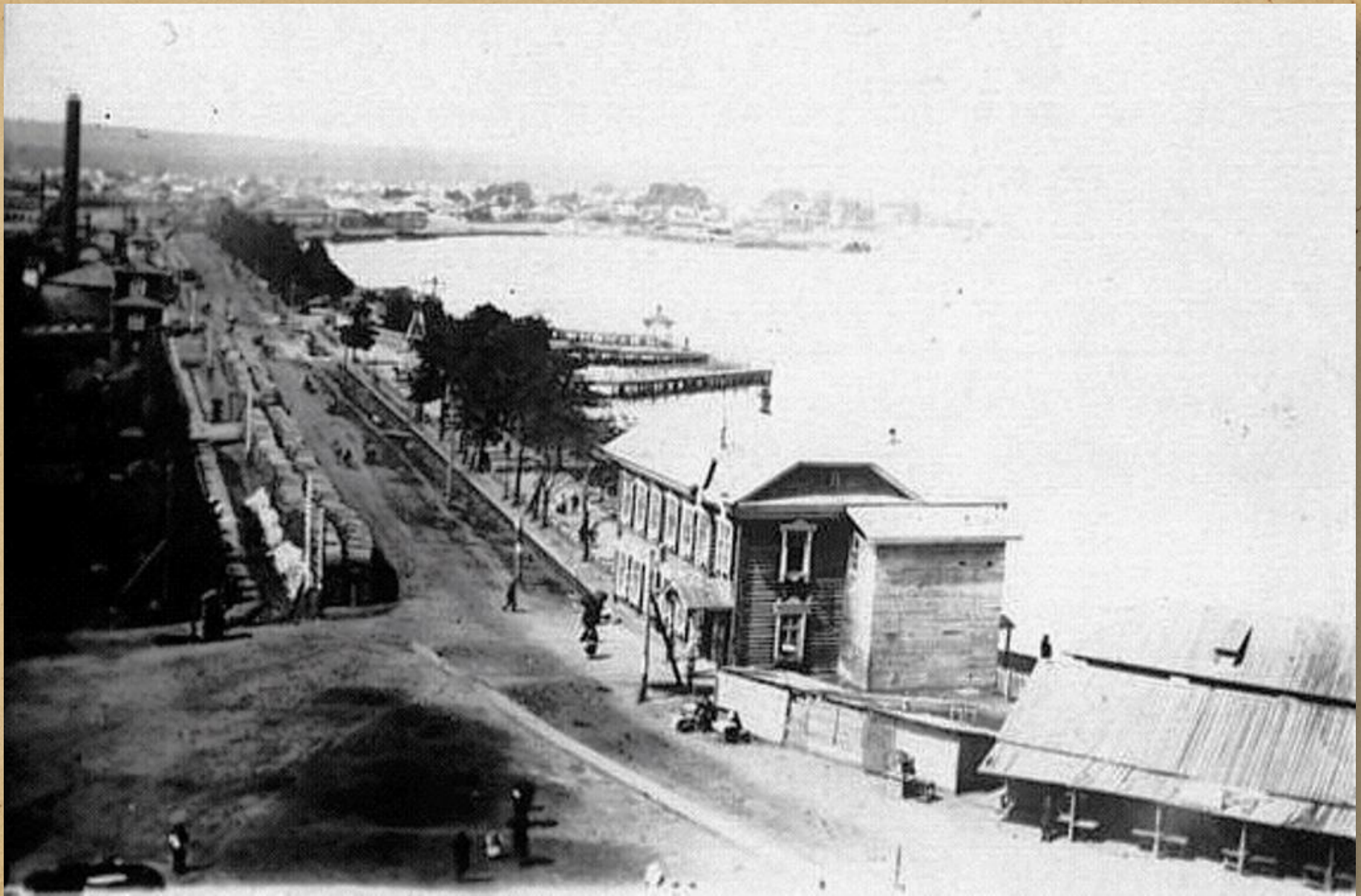
Вид на плотину Воткинского завода нач. XX в. снимок сделан с колокольни Благовещенского собора.
