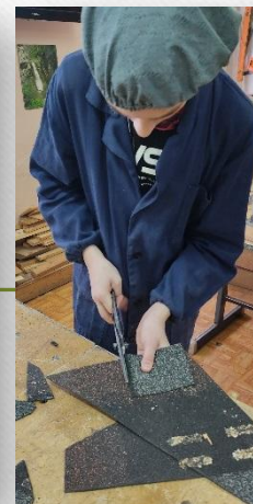
Вырезание покрытия для крыши
