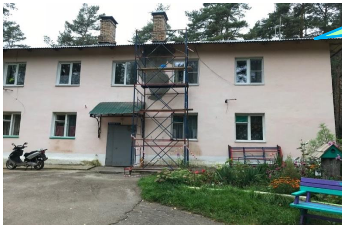
Установка лесов для выполнения работ по ремонту
