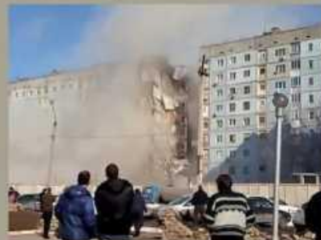
Обрушение здания в Астрахани
