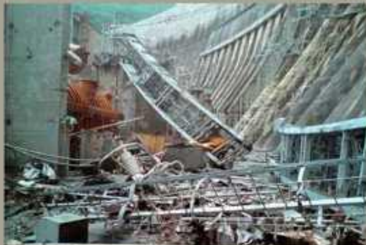
Авария на Саяно-Шушинской ГЭС
