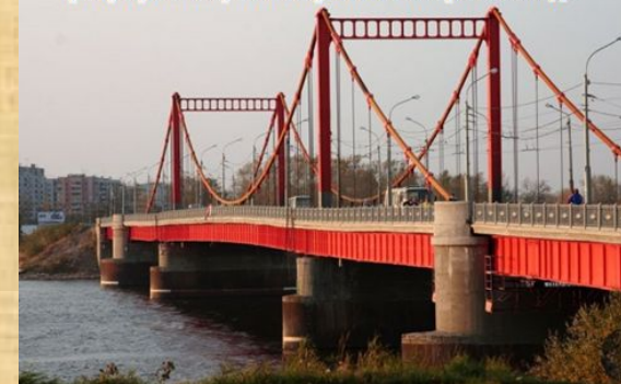
Первый железобетонный мост в Архангельске через реку Кузнечиху был открыт 20 октября 1956 года
