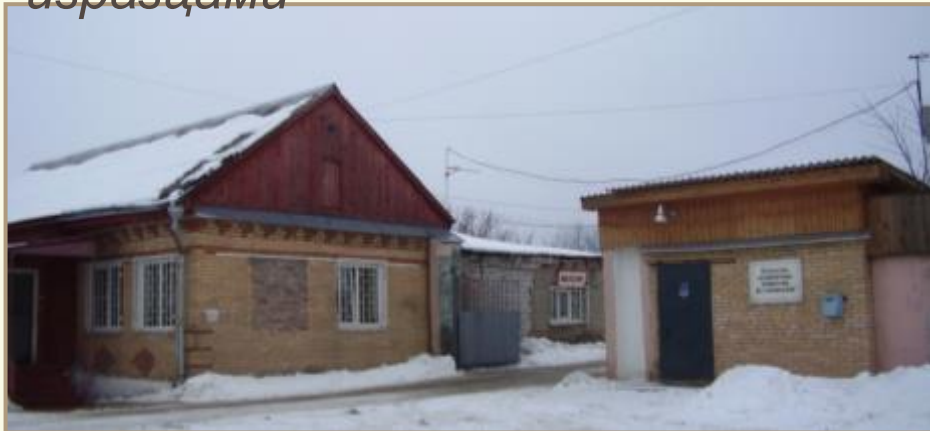
Проходная завода металлоизделий
