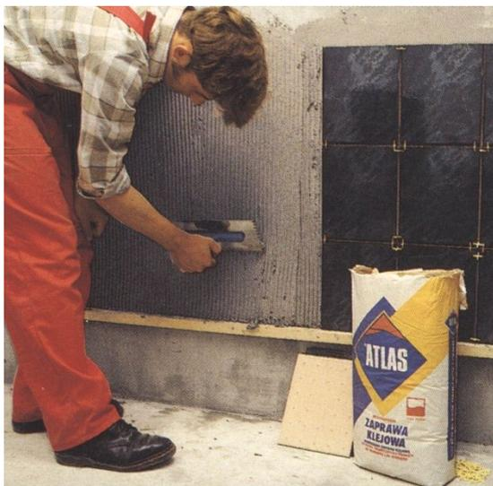
Клеевой раствор равномерно наносят на стену гладкой стороной тёрки, а потом равномерно распространяют по поверхности стены зубчатой тёркой
