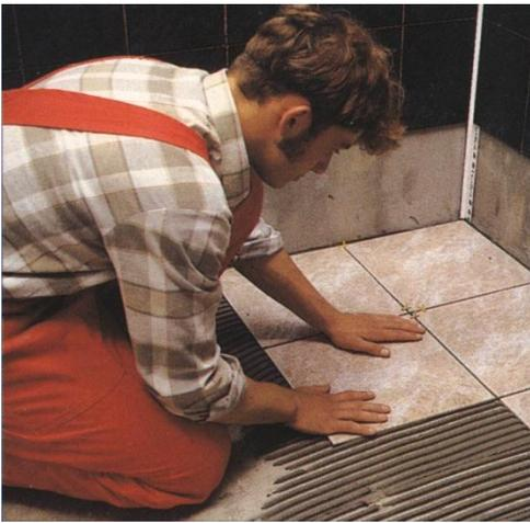
Принципы укладки напольных керамических и других плиток на пол, такие же как при укладке стеновых керамических плиток. Укладку напольных плиток начинаем от наиболее заметного угла в помещении
