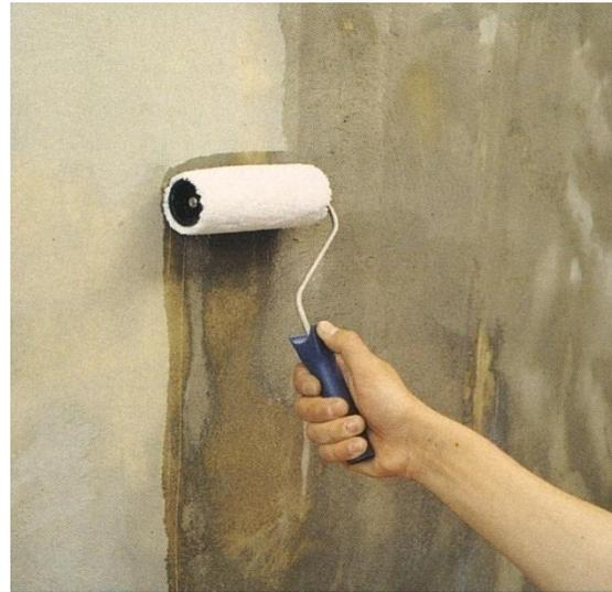
Все места где был нанесен выравнивающий раствор после его затвердевания (минимум 24 часа), покрывают еще раз грунтовочной эмульсией
