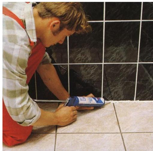
Соединение между стеной и полом силиконовой массой
