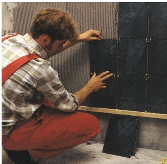
Укладку плиток начинают снизу. Чтобы швы были одинаковые, применяем дистанционные крестики. Плитки, после укладки на стене прижимают рукой, а если плитки большие - подбивают их специальным резиновым молотком. Излишки раствора удаляем, пока он не затвердел. Чтобы правильно приклеить плитку, клеевой раствор должен быть нанесён на всю поверхность плитки.
