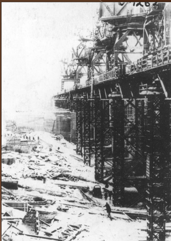
Строительство плотины и здания Новосибирской ГЭС на левом берегу Оби
