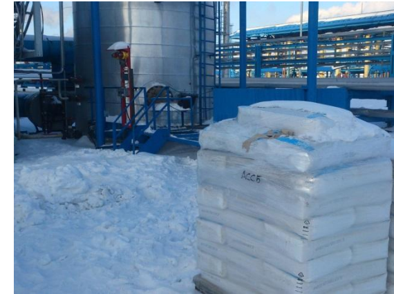
Существующий узел загрузки антиокислительной присадки Агидол
