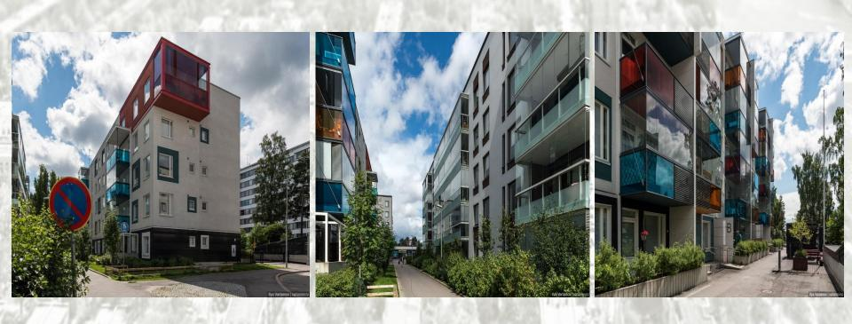
Так как конструкция здания не предполагала наличие балконов, то их закрепили легкой металлической конструкцией к фасаду
