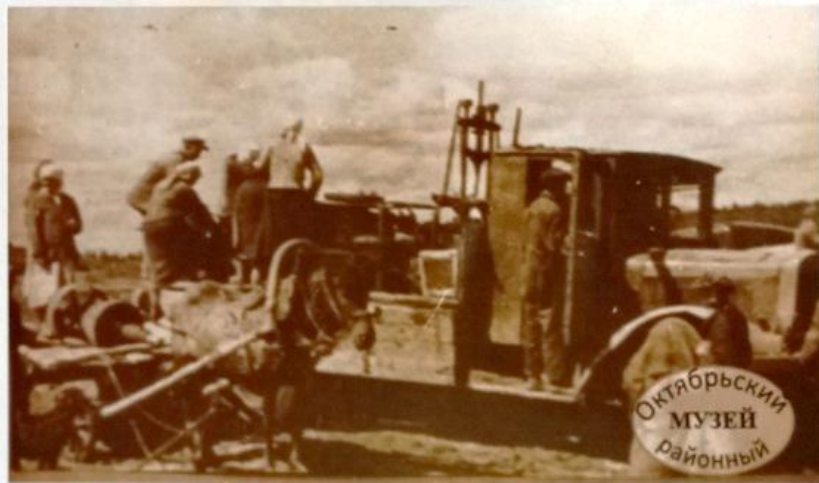
Разгрузка оборудования ЛенЗОСа на ст. Чад. 1941 г.
