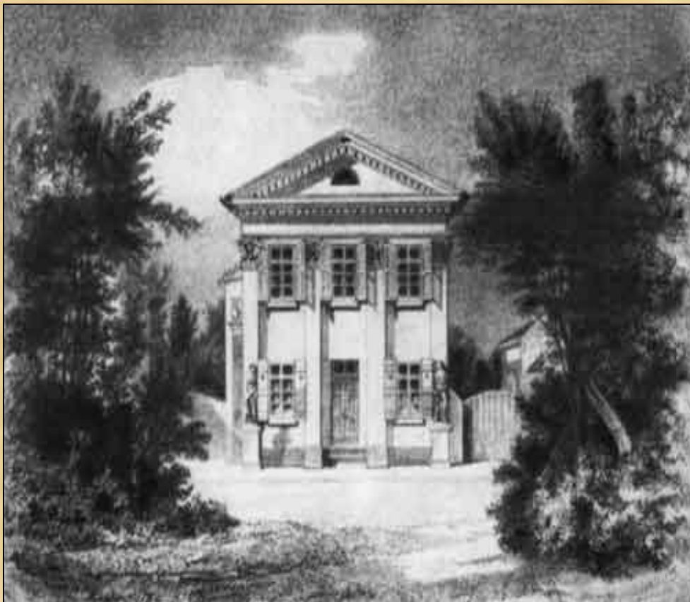
Дом В.А.Жуковского в Дюссельдорфе
