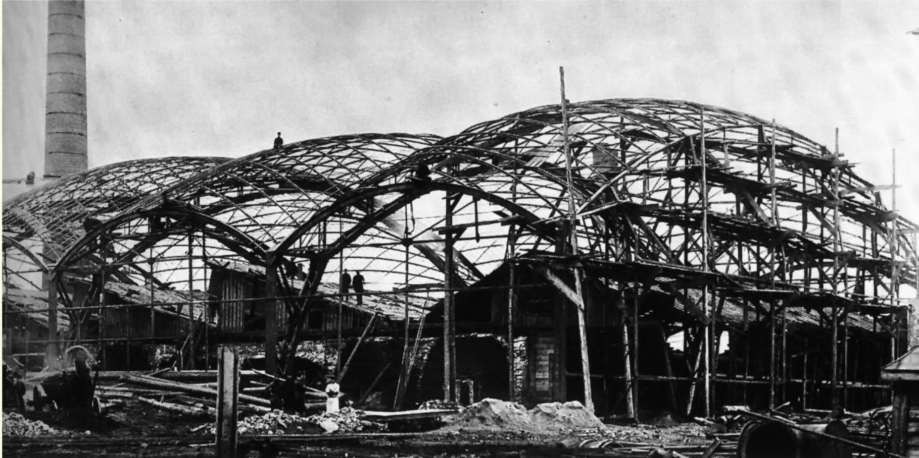
Строительство первых в мире сетчатых оболочек-перекрытий двойкой кривизны конструкции В. Г. Шухова на Выксунском металлургическом заводе, Выкса, 1897
