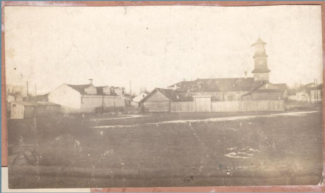
Здание пожарного депо
