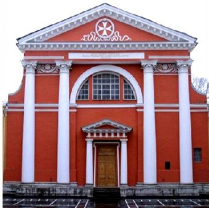
Мальтийская капелла 1798-1800 г. Архитектор Д. Кваренги
