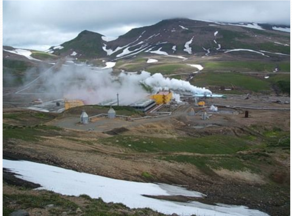
Мутновская геотермальная станция
