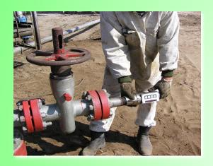
Произвести демонтаж прибора, свинчиванием волномера с затрубиото патрубка.
